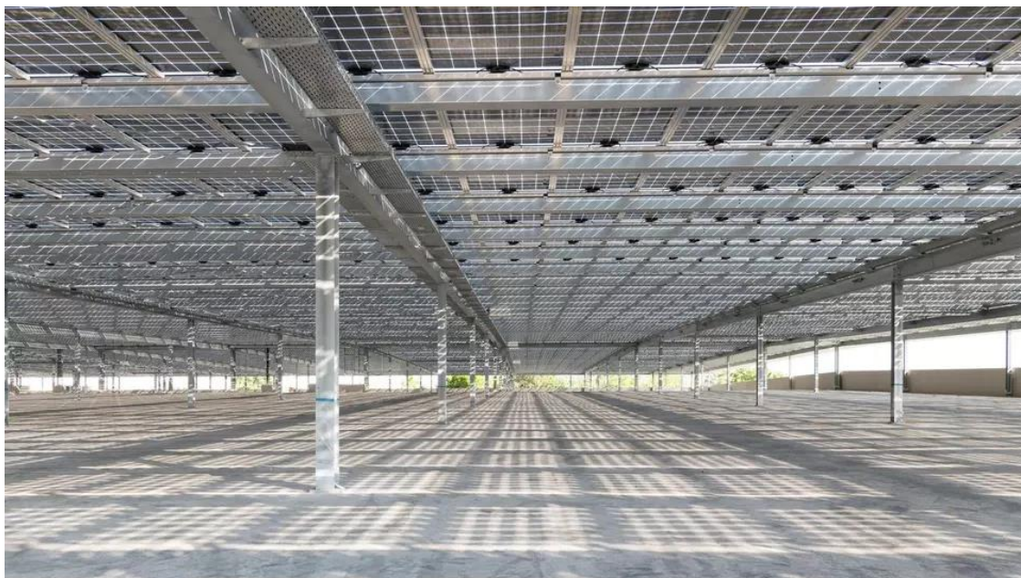
Abbildung 49: Beispiel einer Indach-PV-Anlage
