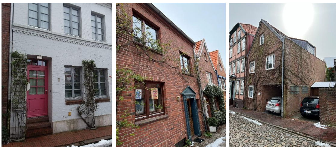
Abbildung 29: Fassadenbegrünung an historischen und jüngeren Klinkerbauten in der Rosenstraße (links), Baumhausstraße (mitte), Bürgerstraße (rechts).
