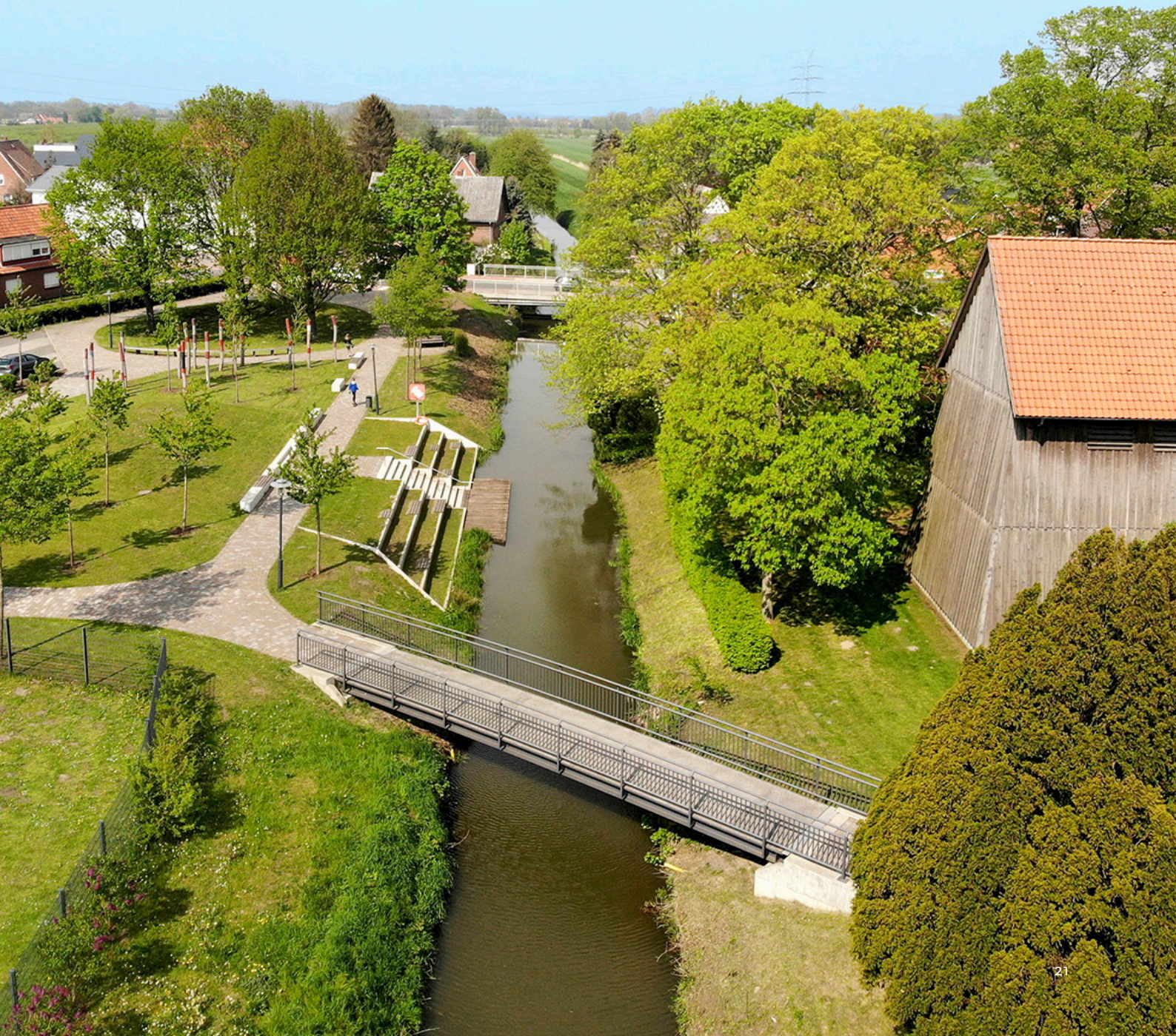
Blick auf den Hörne-Götzdorfer Kanal mit Parkanlage, Brücke und St. Nicolai, 2018
