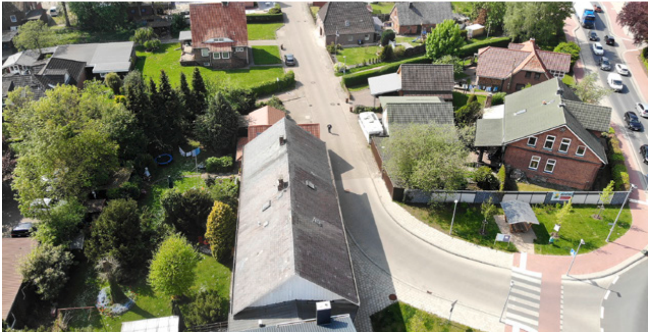
Sanierung Kirchstraße und querender Alter Schienenweg
