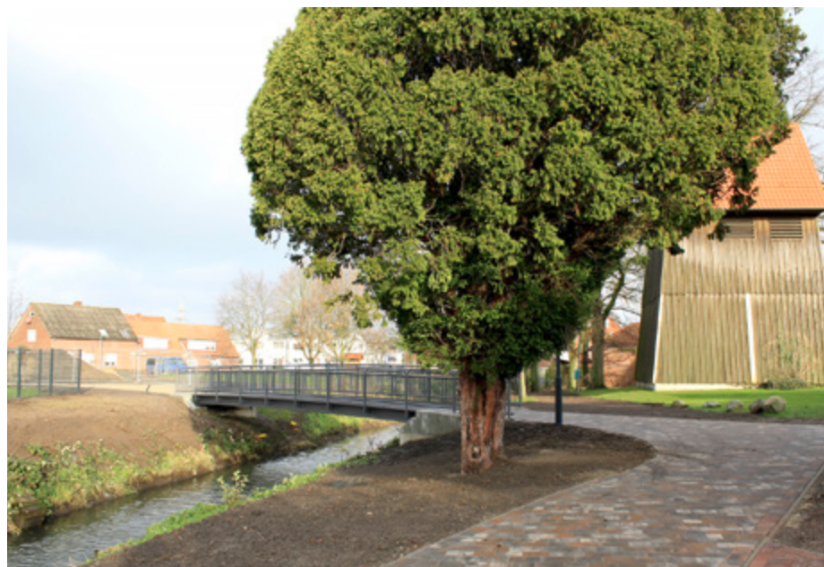
Brückenneubau und Neuanlage des Kajedeichs
