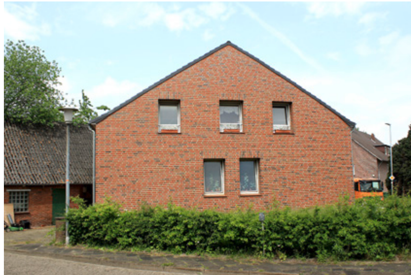
Haus Kirchstraße 2 vor Abriss für den Kreisverkehr
