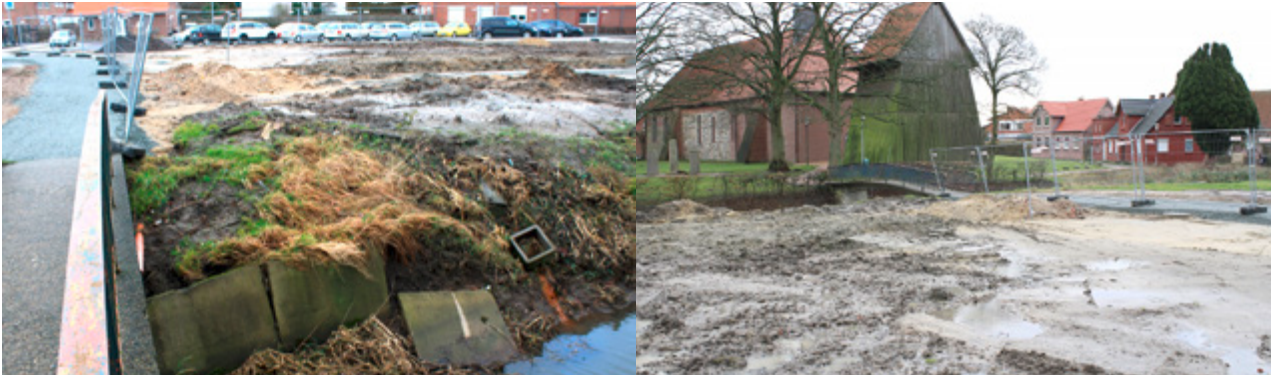
Abriss der alten Kanal-Brücke, Blickrichtung Westen und Südosten zur St. Nicolai-Kirche
