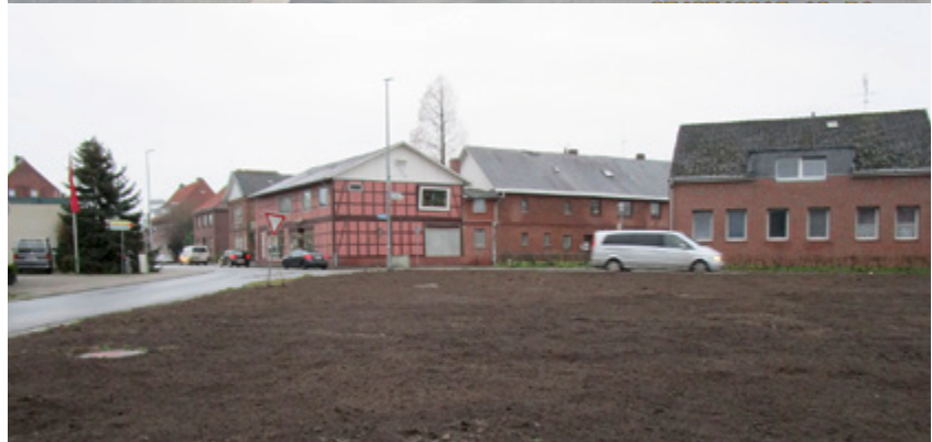
Obstmarschenweg 332 und Deichstraße 1 vor Abriss – freigeräumte Fläche für den nördlichen Kreisverkehr
