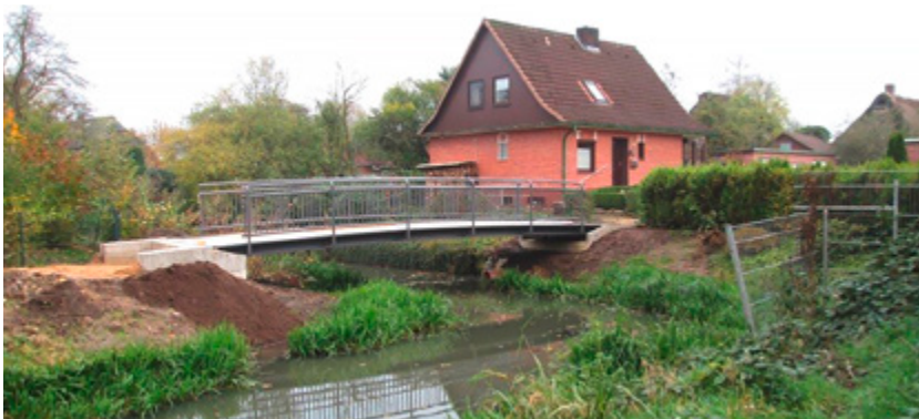
Brückenwiderlager mit zweiter Brücke
