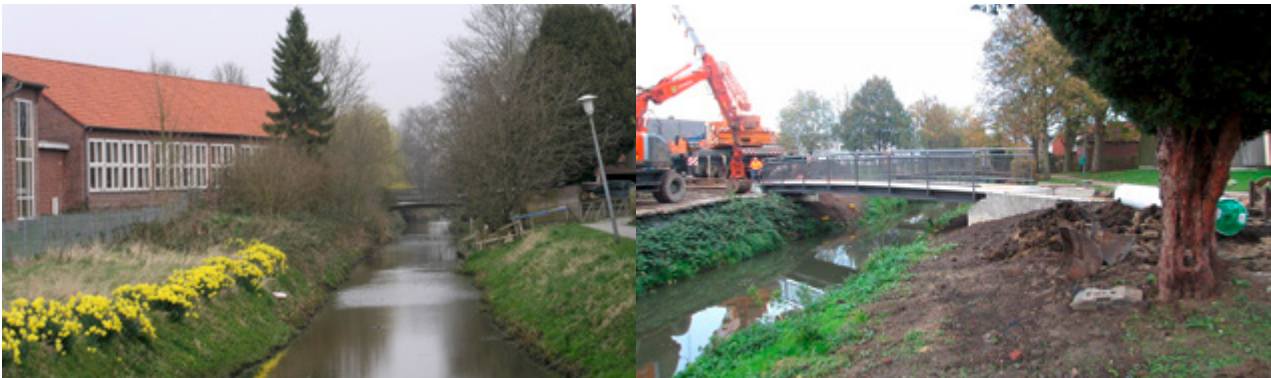
Uferböschung Kajedeich 2009 und Neuanlage mit neuer Kanal-Brücke
