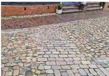
Gesägtes Granitpflaster und Gehwege aus rotbraunem Klinker
