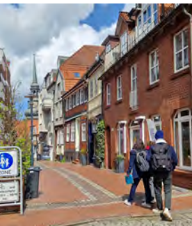
Alte Straße: Klinkerpflaster mit Granitstreifen
