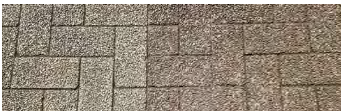
Waschbetonpflaster in der Fußgängerzone
